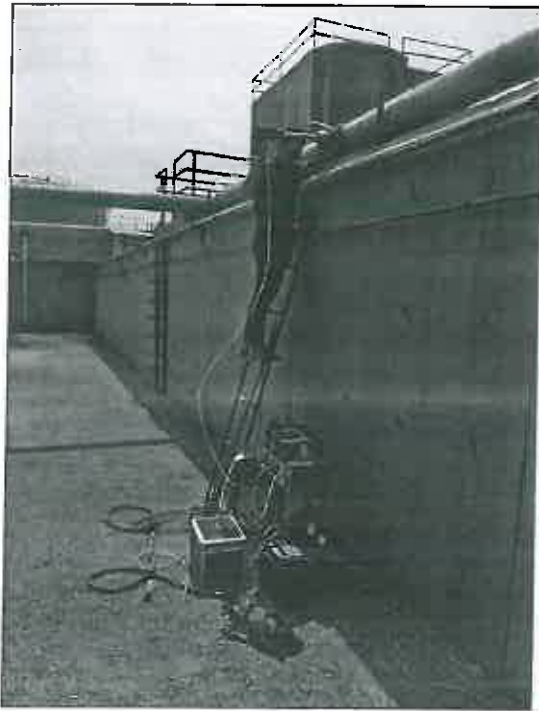
附图 1: DA002 处理设施前 (东) 废气采样
